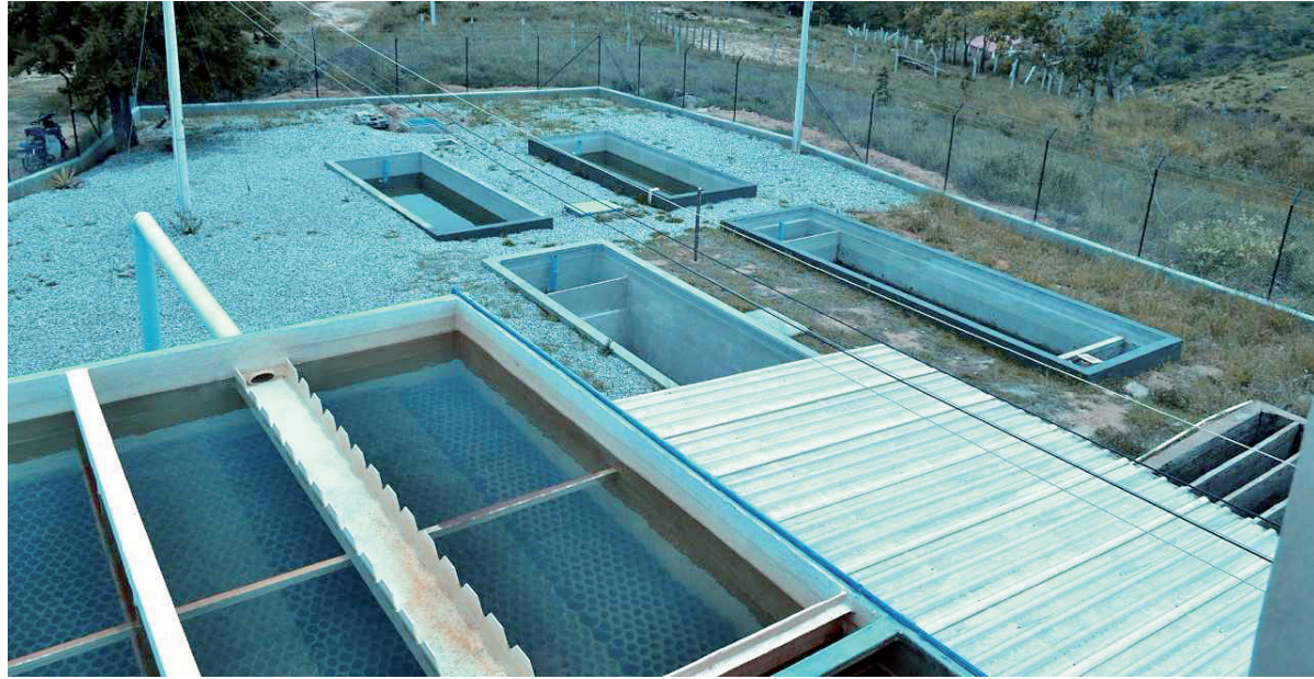
Avances en la obra del acueducto Foto: Karen Barajas
